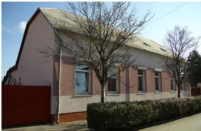
Védett hagyományőrző épület, lakóház, Kossuth Lajos u. 42. ▲
